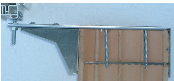
Przekrój – szyna wspomagająca + kątownik
